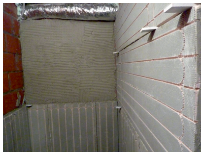
Fot. 2. Płyty izolacyjne xps z rowkami, przygotowane do montażu elektrycznych przewodów grzewczych (fot. z archiwum firmy Elektra Kardo, 2013).
