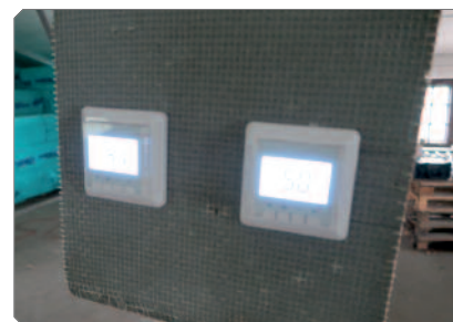
Fot. 2. Elektroniczne termostaty kontrolujące temperaturę powietrza i węzownic.
